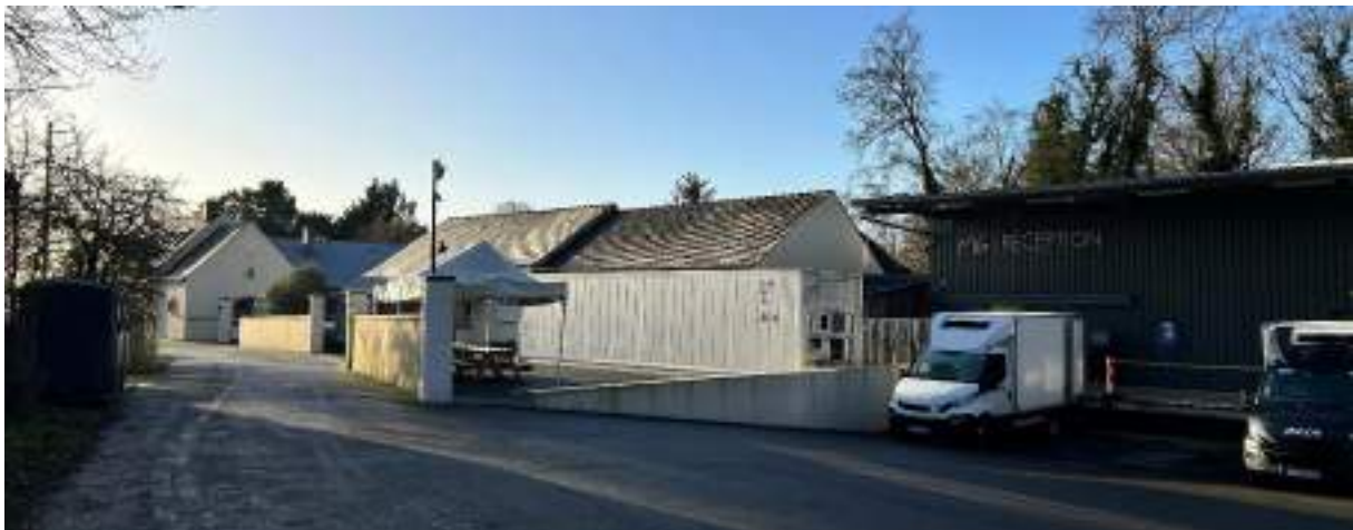
Figure 7 - Le site actuel de l'entreprise MG Réception (Terr&Am - Décembre 2024)
